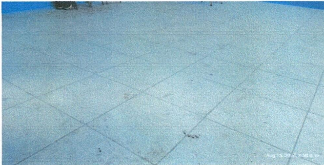
Foto 3: Mejoramiento de piso (Ceramico de alto impacto)
