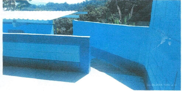
Foto 2: Mejoramiento modulo de corredor.
