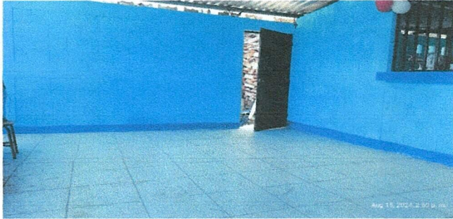
Foto 1: Mejoramiento modulo de corredor.
