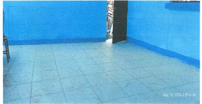
Foto 2: Mejoramiento de piso (Ceramico de alto impacto)
