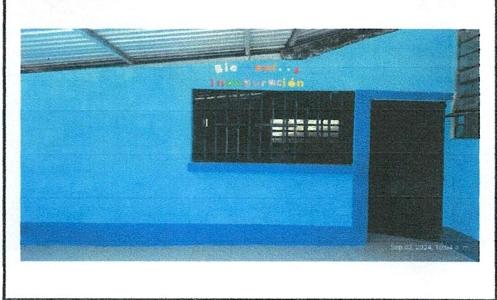
Foto 1: Mejoramiento modulo de cocina.
