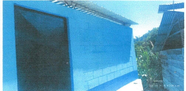
Foto 4: Mejoramiento modulo de corredor.
